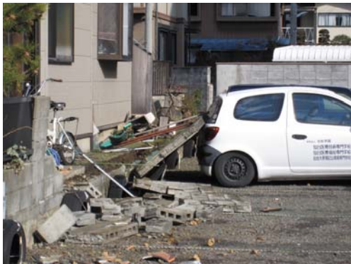
長町小学校区ブロック塀、石塀の倒壊被害の例。ただし、エリア一帯で倒壊率は1978年宮城県沖地震と比較して高くないようです。のきなみに写真のような状況ではありませんでした。
