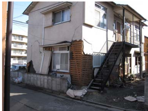
長町小学校区の木造モルタル建物の被害例。建築年代が比較的古い建物のようにです。長町小学校区は、1978年宮城県沖地震で全壊した木造住宅が最も多く発生した場所ですが、住民の方のお話では、振動による被害規模は前回の方が大きかったとのことでした。
