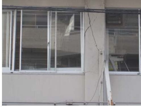
仙台南郵便局（太白区长町7丁目）のRC造の構造被害。
