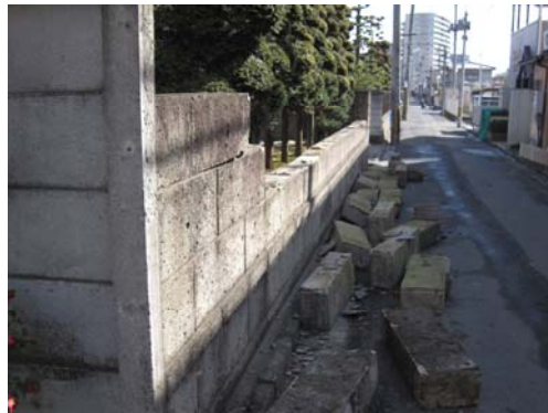
長町小学校区ブロック塀、石塀の倒壊被害の例。ただし、エリア一帯で倒壊率は1978年宮城県沖地震と比較して高くないようです。のきなみに写真のような状況ではありませんでした。
