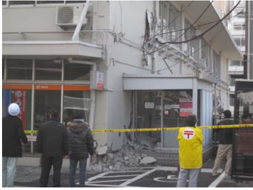
仙台南郵便局（太白区长町7丁目）のRC造の構造被害。
