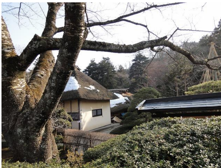
写真 13 有備館（写真奥の建物）の全壊
