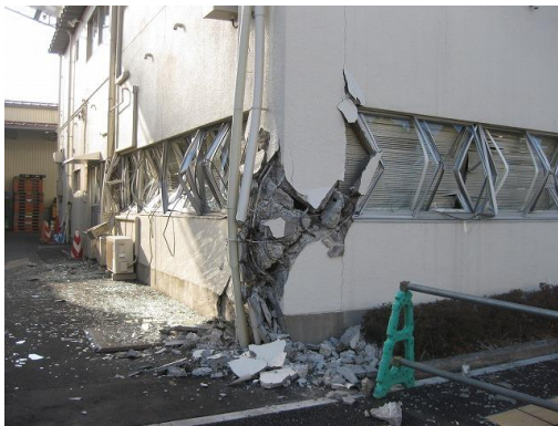
写真 1 3 若林区卸町 3 丁目の RC 造 3 階建ての崩壊
