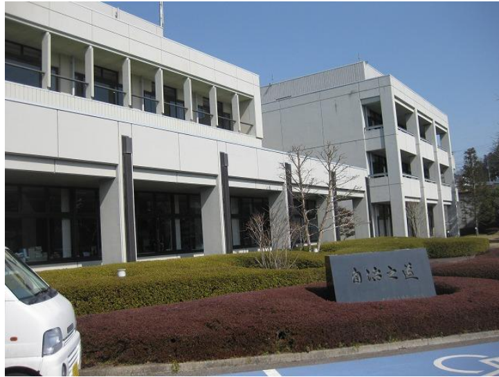
写真 1 大衡村役場外観
