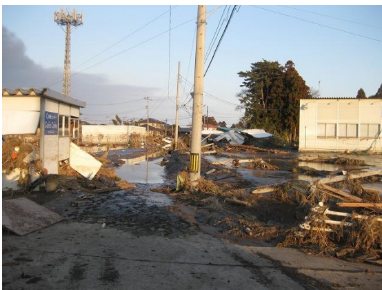
写真２４ 津波被害を受けた宮城野区蒲生付近の様子)
