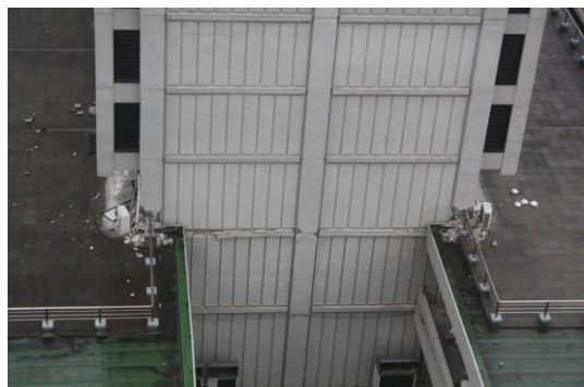
写真 1 人間・環境系研究棟の妻壁 （総合研究棟屋上から撮影）
