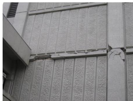
写真 2 人間・環境系研究棟の 3 階部分の 妻壁（地上より撮影）
