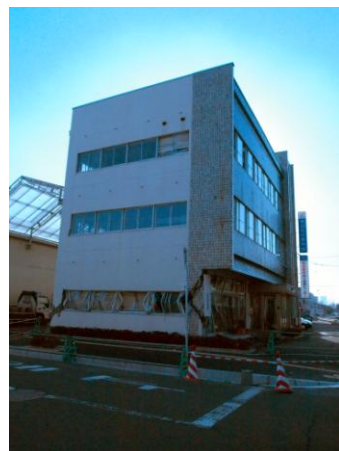
写真 1 3 若林区卸町 3 丁目の RC 造 3 階建ての崩壊
