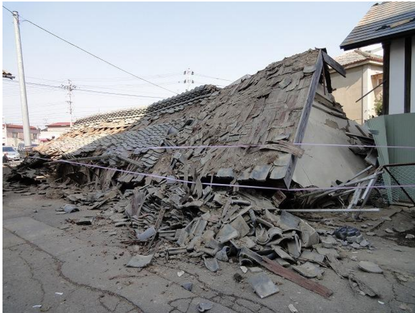
写真 7 土蔵の崩壊（大崎市役所隣）
