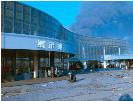
写真２２ 津波により被害を受けた夢メッセ
