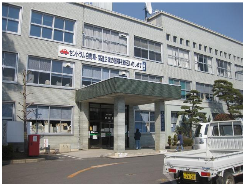
写真 4 大崎市役所（鉄筋コンクリート 3 階建て）
