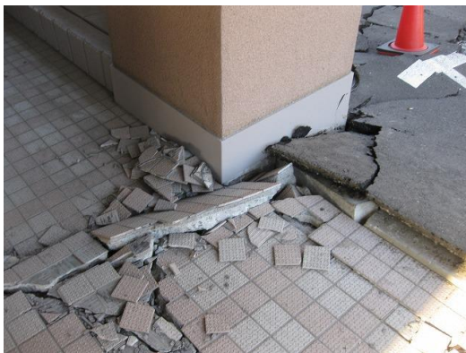
写真１９ 柱脚部周辺の状況
