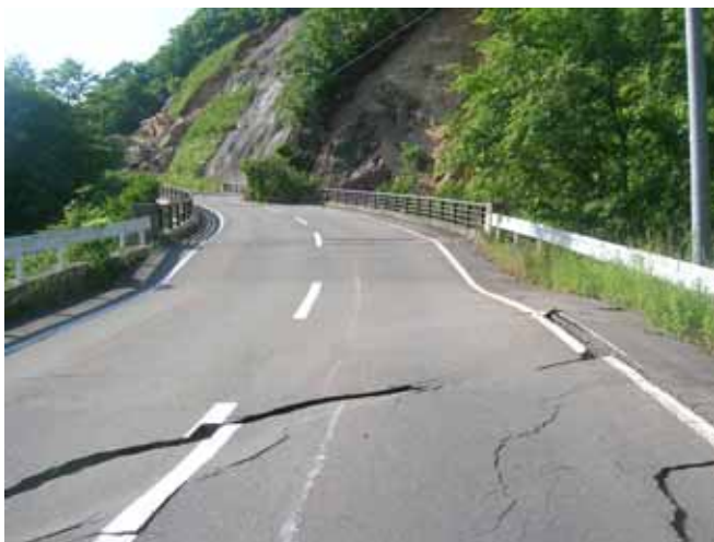
市野々原橋全景
