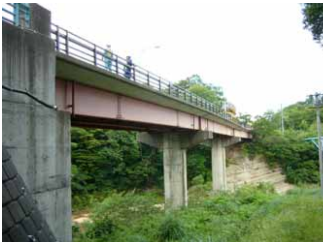
丹寿橋全景 6月17日 片側通行として供用されている。 中間RC橋脚に地震による損傷は認められない。
