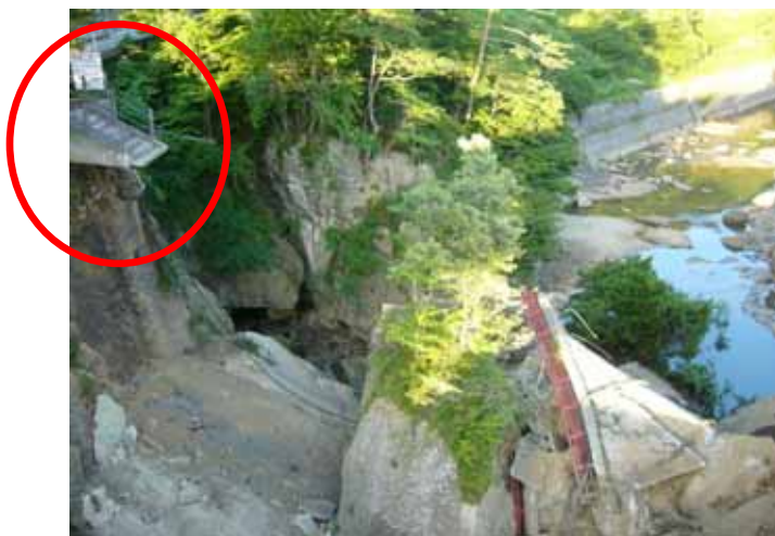
6月16日夕方撮影 歩道橋へのアクセス部(赤丸部)を残し、橋本体は落橋。
