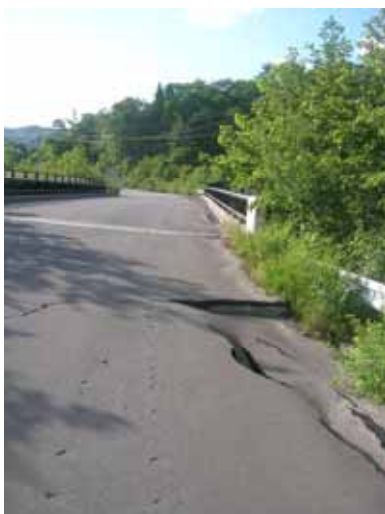
槻木平橋全景 まるつべ大橋から一関側に100mほどの距離にある。
