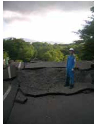
写真3 (左写真：道路の隆起状況，右写真：左写真の道路隆起部の拡大)。 A2橋台背面の道路の隆起。桁がA2橋台に衝突し，一関側に押し込む過程で隆起したと思われる。
