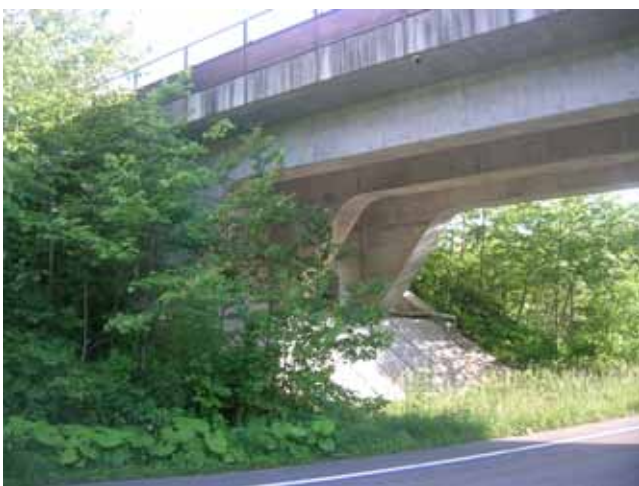
コンクリート桁
