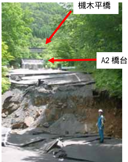
写真 4 A1 橋台背面の地盤滑りの状況 .
