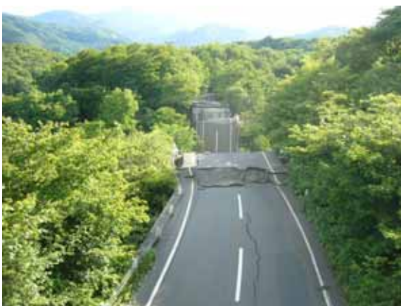
写真3 (左写真：道路の隆起状況，右写真：左写真の道路隆起部の拡大)。 A2橋台背面の道路の隆起。桁がA2橋台に衝突し，一関側に押し込む過程で隆起したと思われる。
