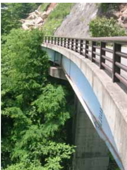
中間 RC 橋脚 柱基部を見ることができないが、遠方からの外観 観察では、損傷は認められない。
