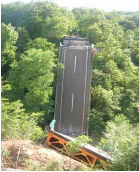
写真1 奥に見えているのがA1橋台。
